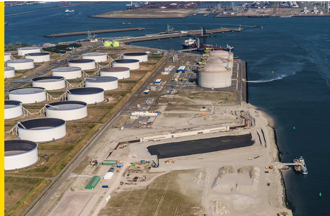
LNG Breakbulk Terminal
