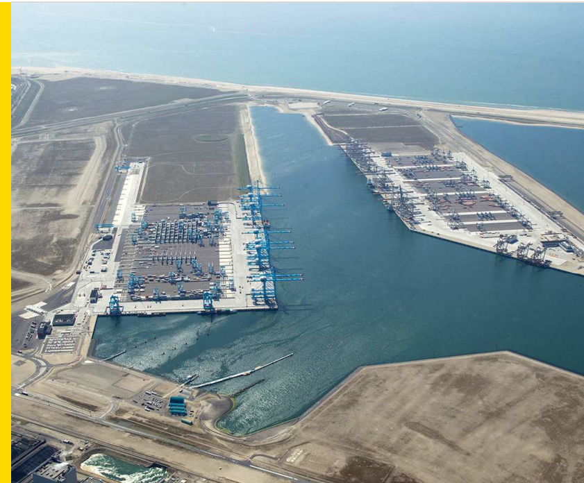
Maasvlakte 2 container terminals
