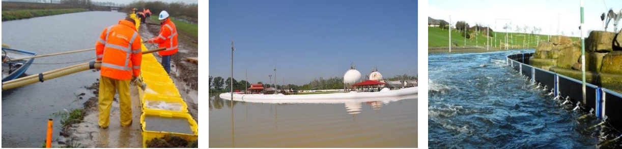
Voorbeelden van noodkeringen: Box Barrier (links), systeem gevuld met lucht (midden) en vrijstaand keermiddel (rechts).
