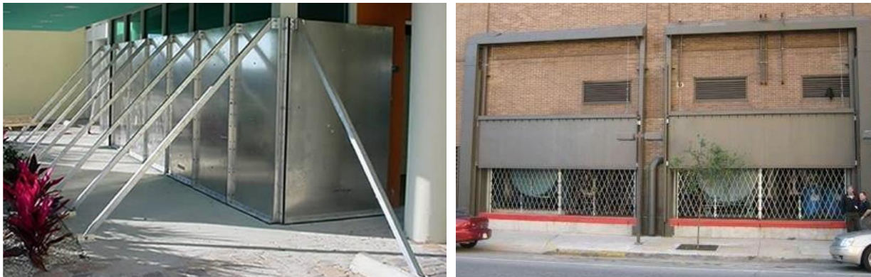
Foto. Voorbeelden van 'Dry proofing' met panelen om een gebouw waterdicht te maken (links) en waterdichte deuren die gesloten kunnen worden (rechts).
