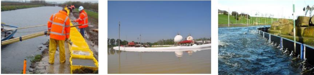
Figuur 15. Voorbeelden van noodkeringen: Box Barrier (links), systeem gevuld met lucht (midden) en vrijstaand keermiddel (rechts).
