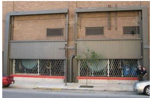
Foto. Voorbeelden van 'Dry proofing' met panelen om het gebouw waterdicht te maken (links) en waterdichte deuren die gesloten kunnen worden (rechts).
