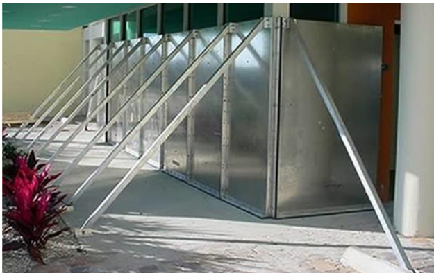
Foto. Voorbeelden van 'Dry proofing' met panelen om het gebouw waterdicht te maken (links) en waterdichte deuren die gesloten kunnen worden (rechts).
