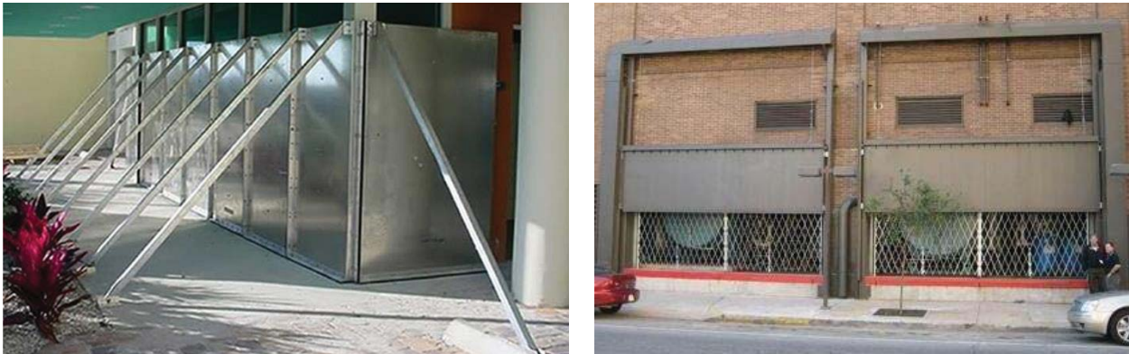
Foto. Voorbeelden van 'Dry proofing' met panelen om het gebouw waterdicht te maken (links) en waterdichte deuren die gesloten kunnen worden (rechts).
