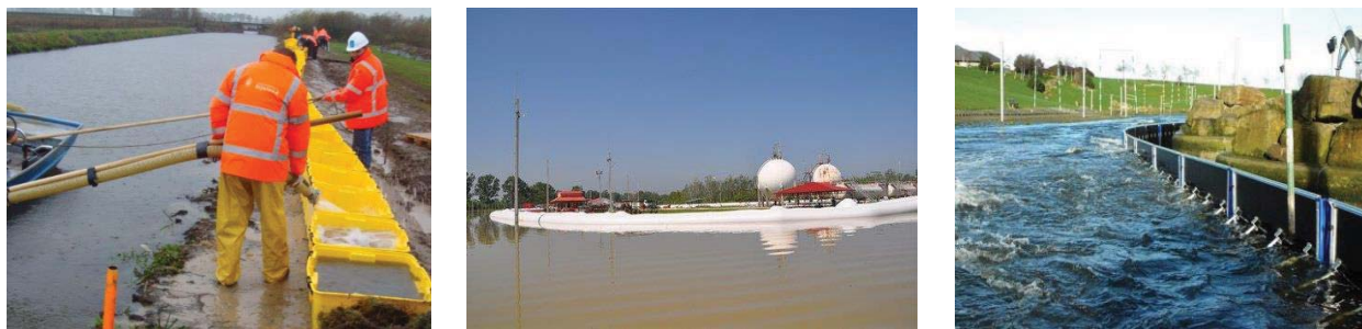
Figuur 27. Voorbeelden van noodkeringen: Box Barrier (links), systeem gevuld met lucht (midden) en vrijstaand keermiddel (rechts).
