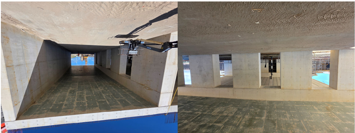
Eindresultaat na verwijderen bekisting
