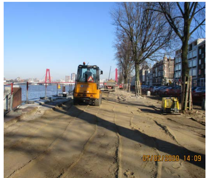
Vorbereidingen voor het aanbrengen van de bestrating.
