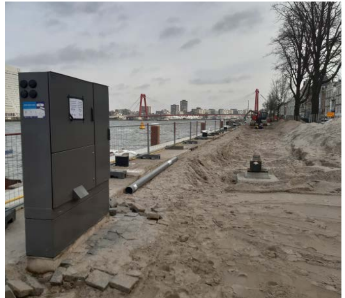
Walstroomkast en kolkaansluiting op het nieuwe riool.
