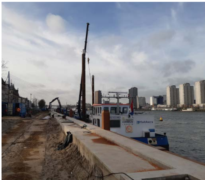
Het m.s. Cornelis is bezig met het aanbrengen van de laatste zaken als borden en wrijfhout.
